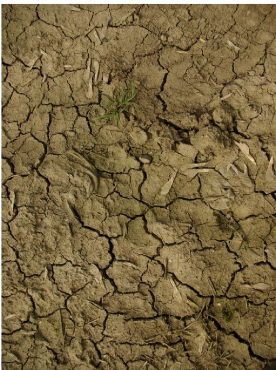
Obr. 14b STŘEDNĚ DOBRÝ STAV (VS = 1): na povrchu se vytváří 2–3 mm silná krusta a povrch je prokazatelně zbrzděný prackami nebo je půdní povrch kryt ze 30–70 %.
